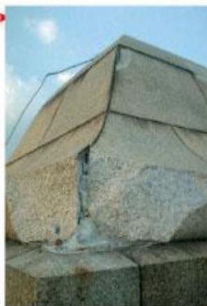
議事堂のまさに最頂部に生じた破損。2 段目の小さい破損も今回修復された。
