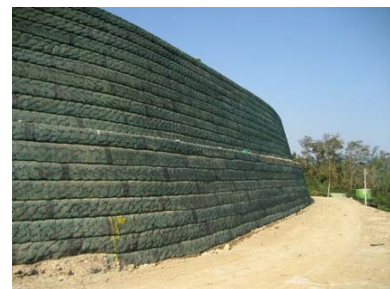
加勁擋土牆完工貌
