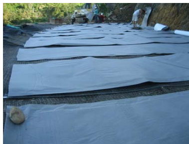
底層排水板鋪設
