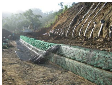
加勁擋土牆施工
