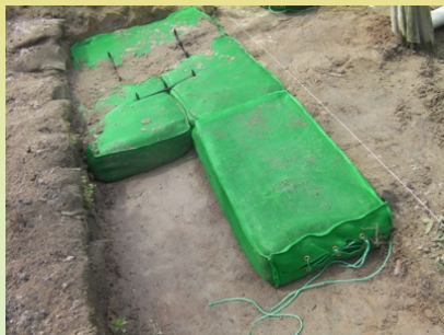
基礎整平夯實堆疊
