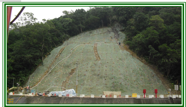
網毯釘掛鋪設
