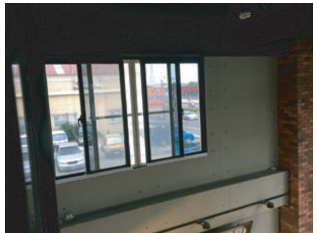
@木工坊挑高展示間。開啟雙面高處通風窗，可連動，可無線遙控。
