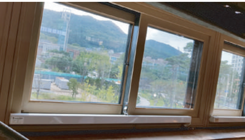
@南韓國小體育館。可連動開啟整面牆之高處氣窗。具無線遙控功能。
