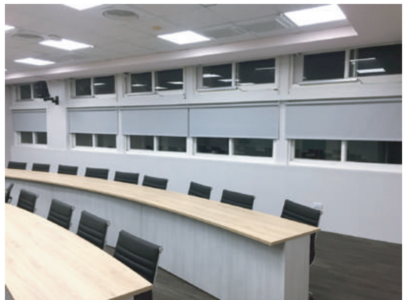
@學校講堂。採用KST-SL02，作為消防排煙窗及連動開啟高處通風窗用。
