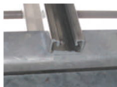
鍍鋅鋁鎂鋼板的切割端面修補
