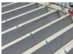
鋼板屋頂的螺栓部分加強
