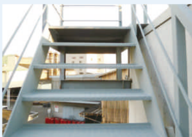
室外鋼筋樓梯
