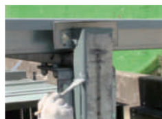
鍍鋅面上直接塗刷
