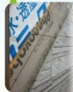
本鋼骨建築採用外斷熱工法，將外側全部以隔熱材包裹，介於外裝材間再以空氣層做為斷熱。也因此氣密性與斷熱性很好，提供冬暖夏涼的舒適住宅環境，不需要擔心因牆壁的結露現象而發生發霉甚至壁癌的產生。
